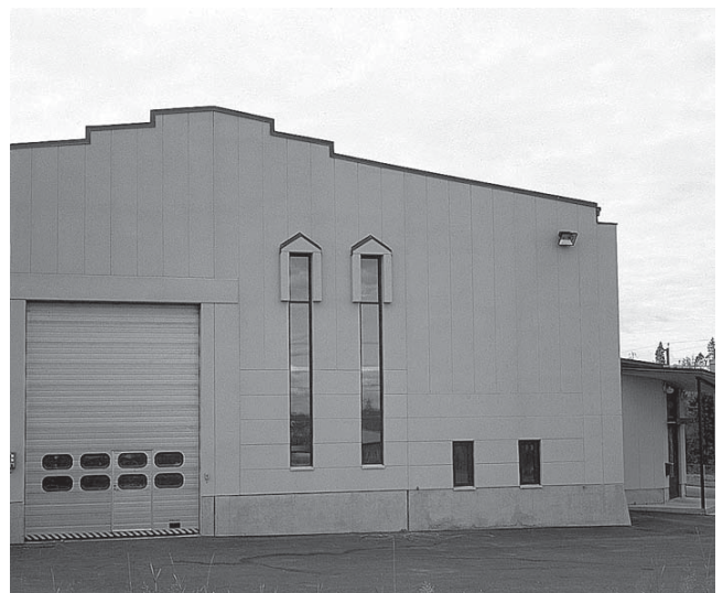
Vaaka- ja pystyelementtirakenteet.
